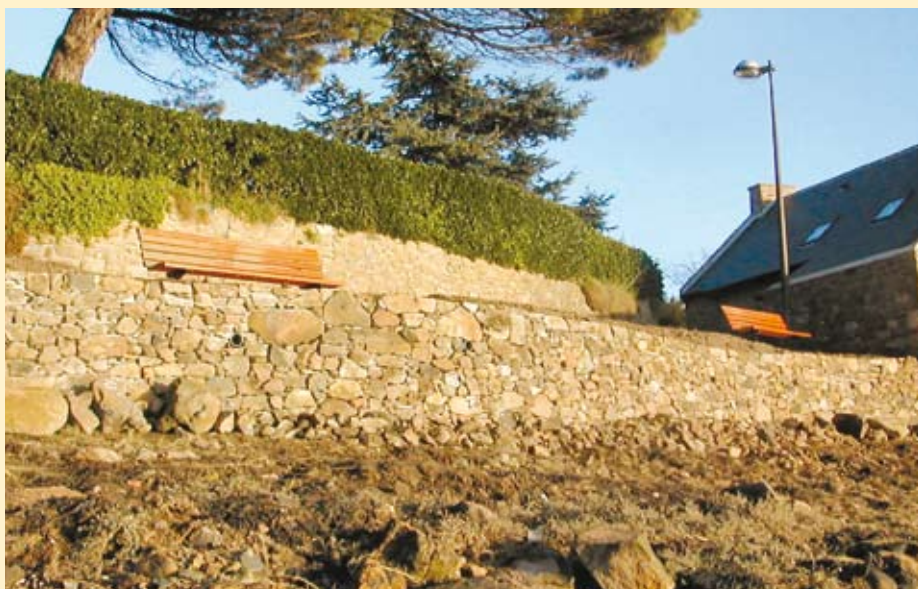
Travaux de défense contre la mer au Birlot
