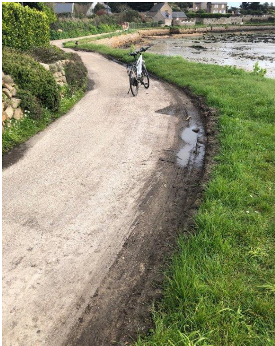
Sections au nord de la Corderie
