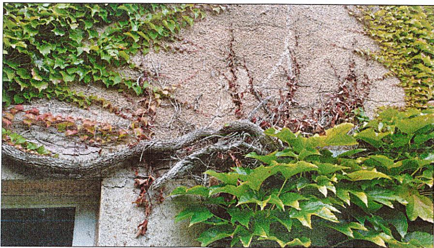
Mur de façade Sud présentant un dévers en son centre de près de 9cm sur 4 mètres de hauteur et de nombreuses fissures horizontales
