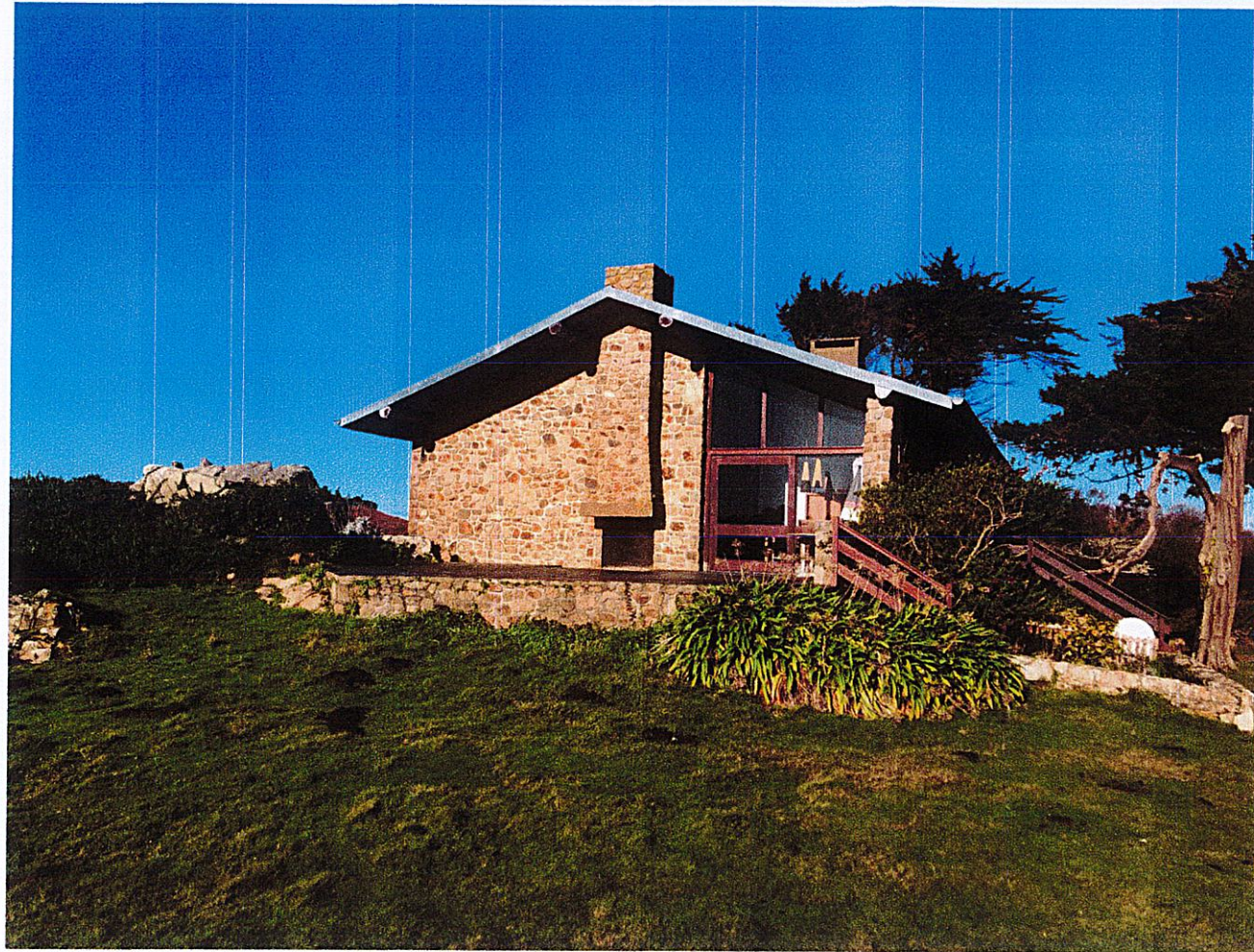
Vue de la maison façade Sud.
